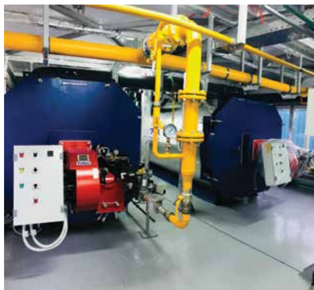
Строительство водогрейной котельной мощностью 6 МВт для АО «Оренбургнефть» (ПАО «НК «РОСНЕФТЬ»)
